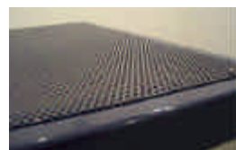
Lochblech auf dem Ofen gegen Hitze und Feuchtigkeit
